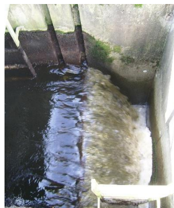
Photographies n° 2 : Travaux de restauration de la continuité entre le cœur de l'étang et le moine
